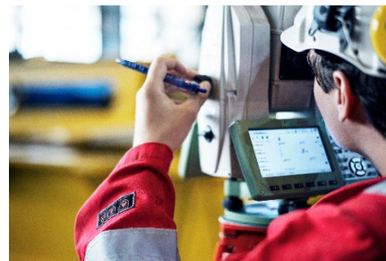
Vetle opererer totalstasjonen
