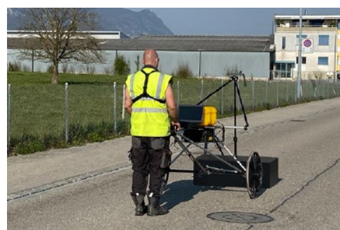
Feltutførelse ifm. inspeksjon av drikkevannsledning
