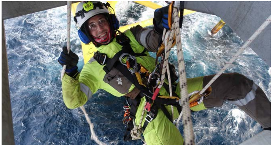
Nikolai Uzunov utfører NVI på innfesting rundt heissjakt på Johan Sverdrup
