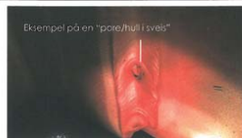
Bilde over viser en sammenføyning/sveis på en konstruksjon.
