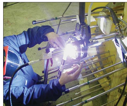
Figur 6 Orbital sveising av terminering
