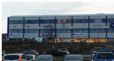
MOST Solutions AS; Verkstedveien 11
