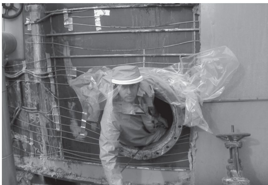
Inspektør og artikkelforfatter på vei ut av lagertank for svovelsyre
