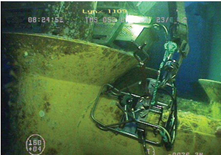
F-EIM installert ved en sveis som skal verifisere en sprekk.
