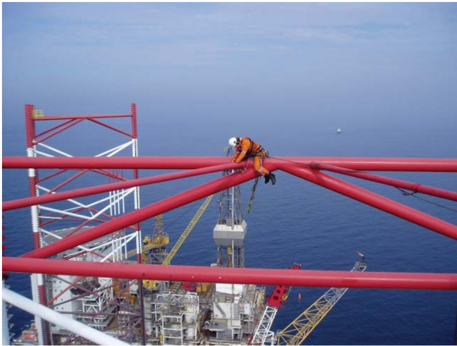
Virvelstrømprøving på Mærsk Innovator. Lufdig arbeidsplass.
