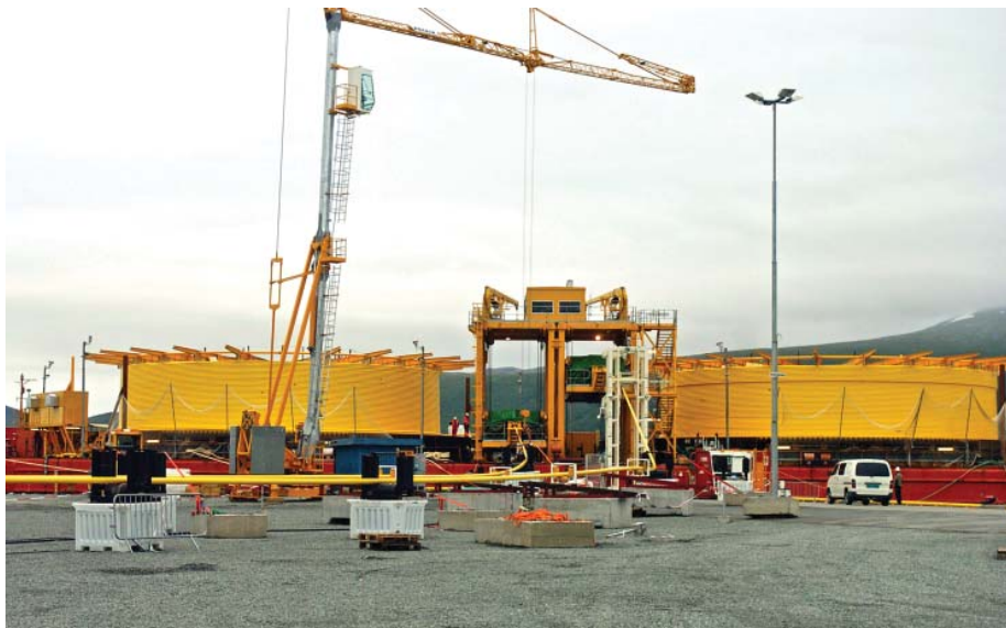
Et fartøy ligger i Breivika og tromler inn rørledningene som legges fra Melkøya til Snøhvit.
