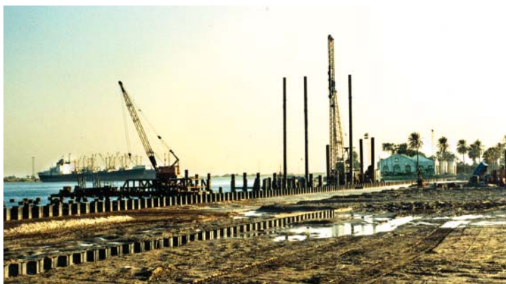
Den nye containerhavnen i Port Said er under utvikling, med spuntvegger i grunnen på land, mens store stålrør pøles i sjøgrunnen.
