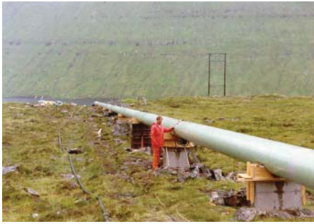
NDT prøving av rørgate på Færøyene.
