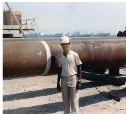
Det var store dimensjoner over både rør og spuntvegger i Port Said. Her med en lokal hjelpemann.
