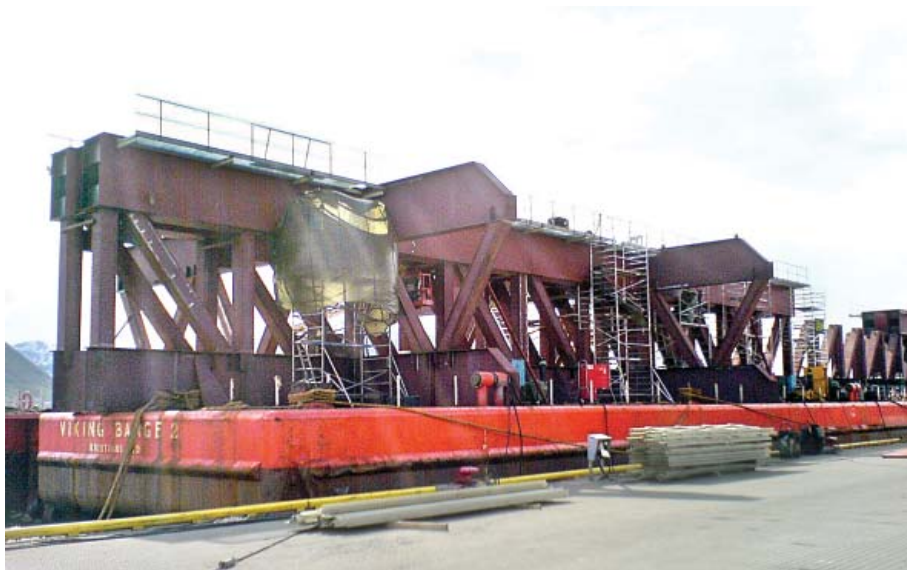
Det var store dimensjoner over stålkonstruksjonene, som ble bygd på lekterne.
