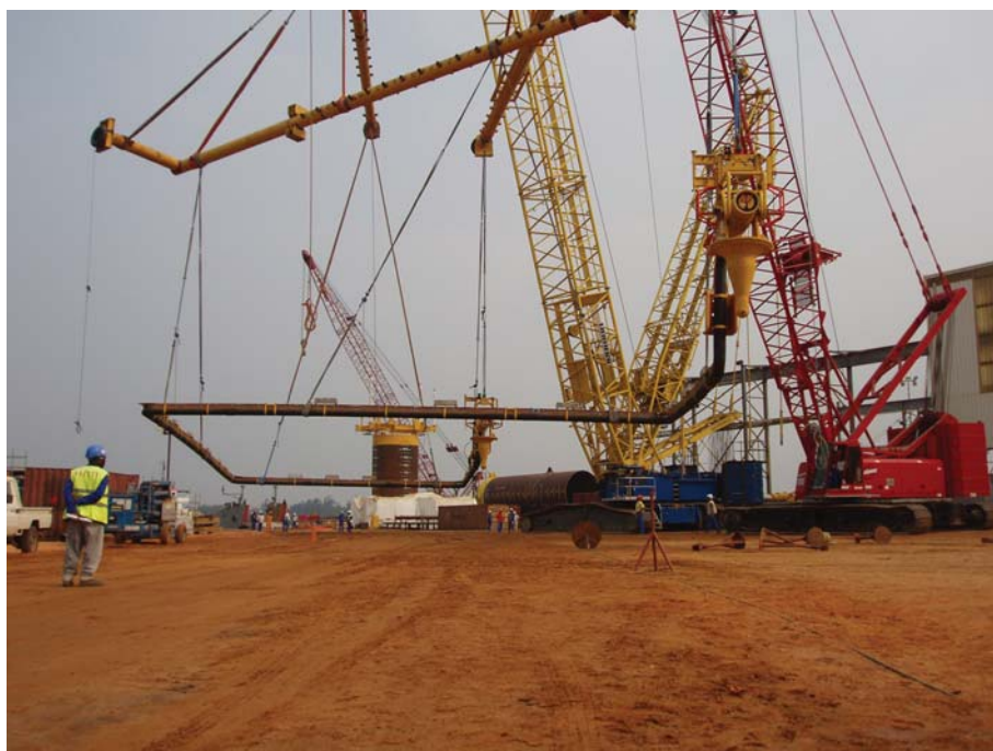
Well Jumper fabrikert i Angola, under load out. Inneholder 6" + 2" rør med et termineringshode i hver ende. Her er det 100RT+DP av alls sveiser.
