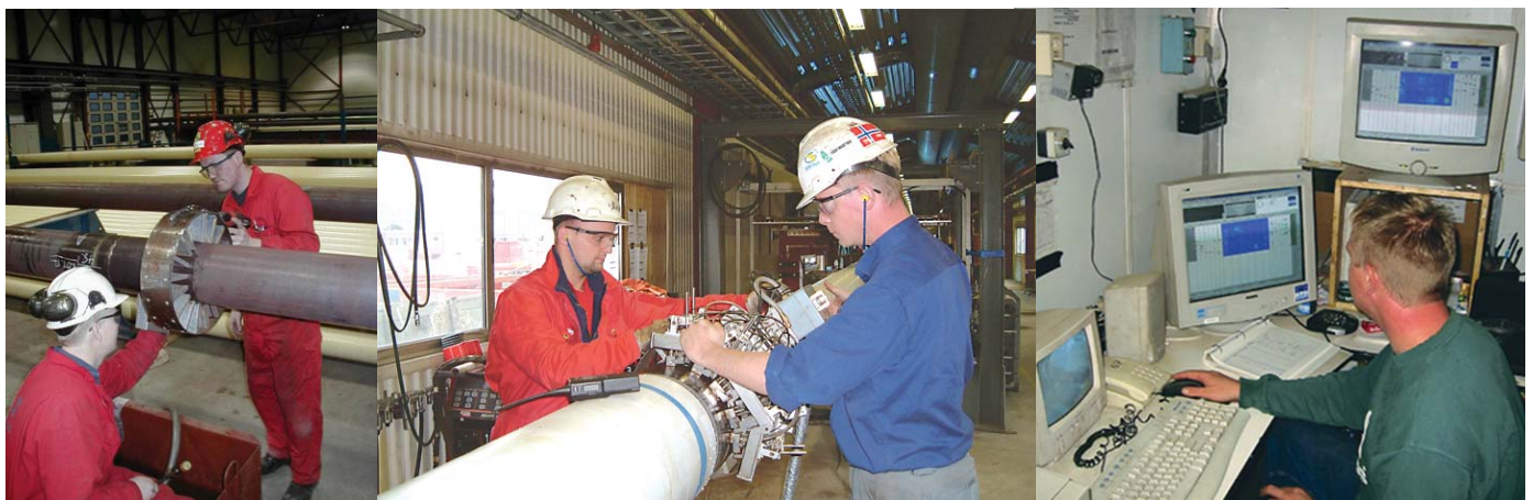
Bilde til venstre: Montering av bånd for scanning av to stk. 12 m rør som gjøres før coatingen påføres. I bakgrunnen kan man se ferdig coatede rør som blir 24 m lange. Bilde i midten: Scanning og bildet til høyre: Beslutningen tas (hurtig!)
