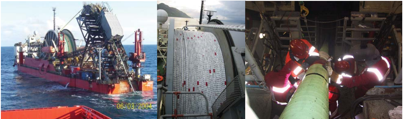
Bildet viser rørlegging fra skip, oppkveliling av rør og pipelinesveisere
