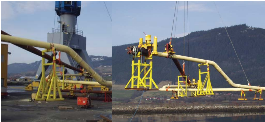
Fabrikasjon av tie-in spools krever mye fabrikkasjonsoppfølging. Dette er typiske prosjekter som våre inspektører reiser rundt og deltar i.
