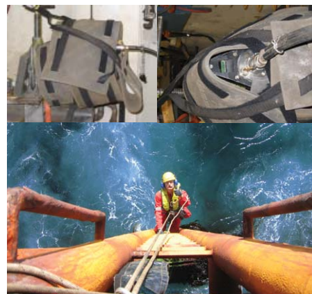
Slik kan omgivelsene til en driftsinspektør se ut. Bruk av SafeRad og TT ifm. driftsinspeksjon.
