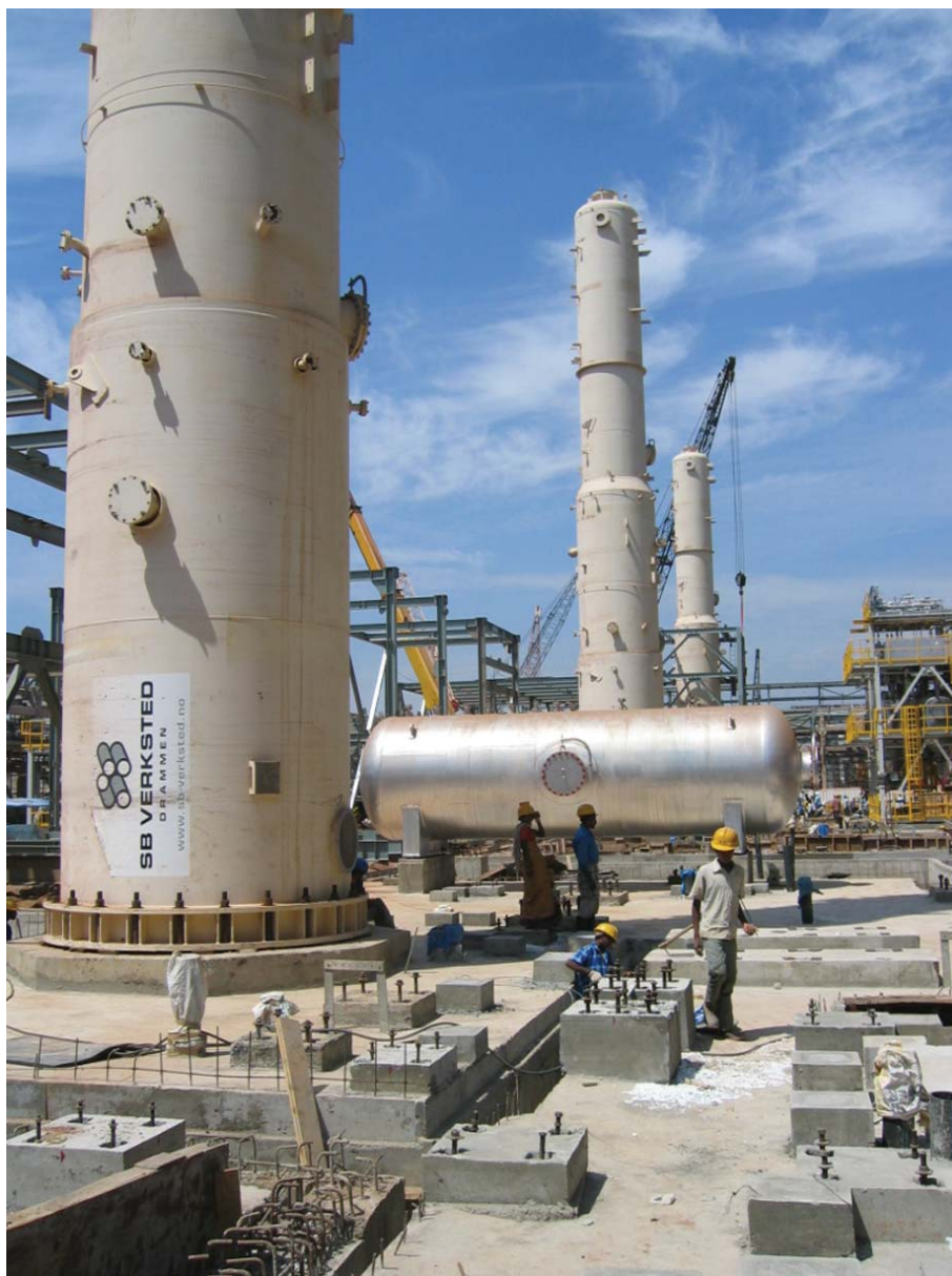
Innallasjon av kolonner til Reliance - India
