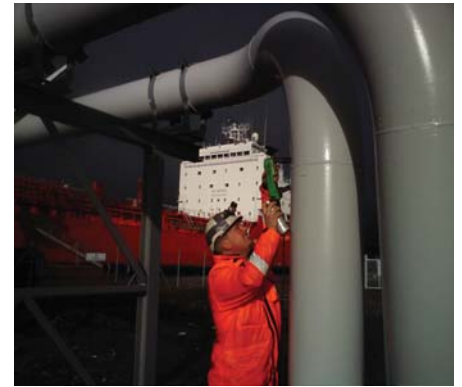
NDT utførelse ved Alekselas tankanlegg på Slovåg
