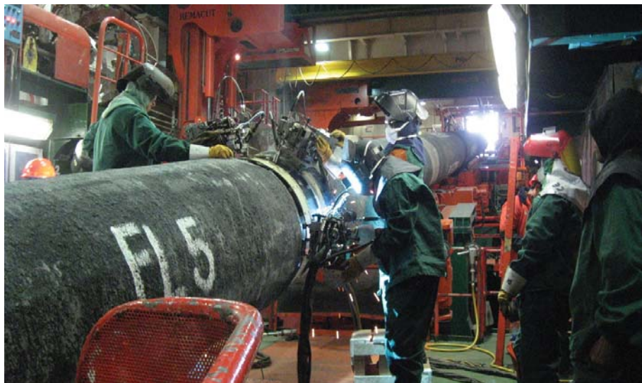
Inspeksjon av rør på et rørleggingsfartøy på Ormen Lange prosjektet
