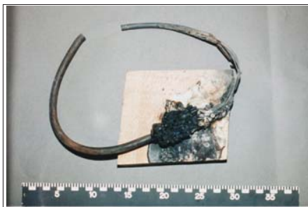
En brannskadd skjotekontakt.
