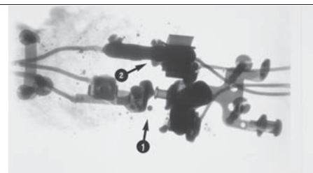
Røntgenfoto av kontakten. Pil 1 viser til området hvor seriebuespen har oppstått. Pil 2 viser til området med lysbuespor etter kortslutning.
